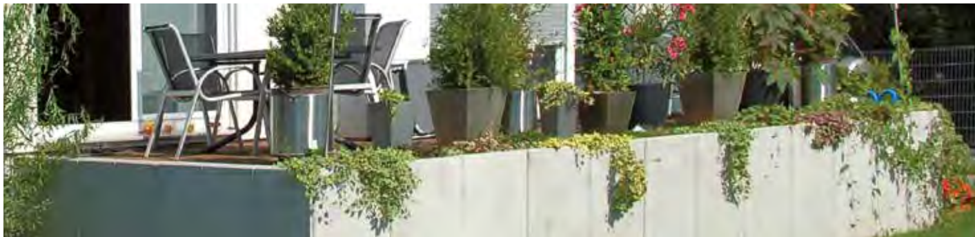
Winkelstützwände Sichtbeton, grau
