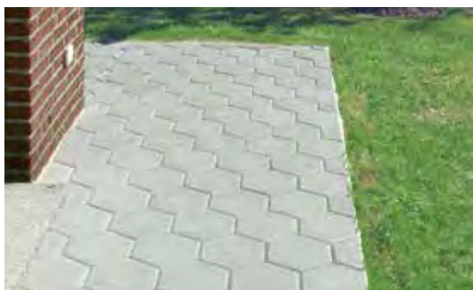
Sechskant-Pflaster mit Fase, 23×20 cm, grau Halbstein und Anfängerstein bauseits geschnitten
