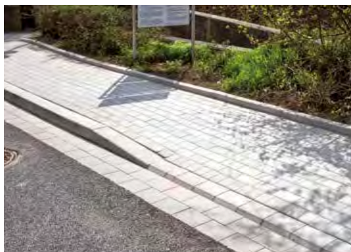
Hochbordsteine H 18×30, Schrammbinder mit 3 cm Abschrägung, Bindersteine, Requa 8er-Pflaster, Tiefbordsteine, grau
