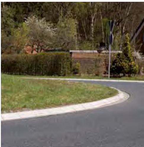
Flachbordsteine in einer Kreisverkehrsanlage
