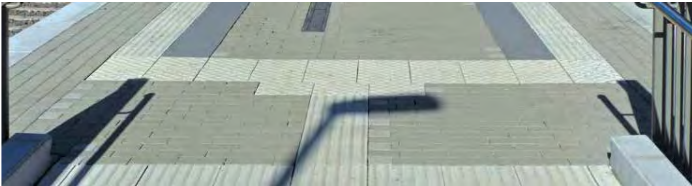
Barrierefrei erstellte Verkehrsanlage nach den Leitlinien von Straßen.NRW für sehbehinderte oder in ihrer Mobilität eingeschränkte Menschen
