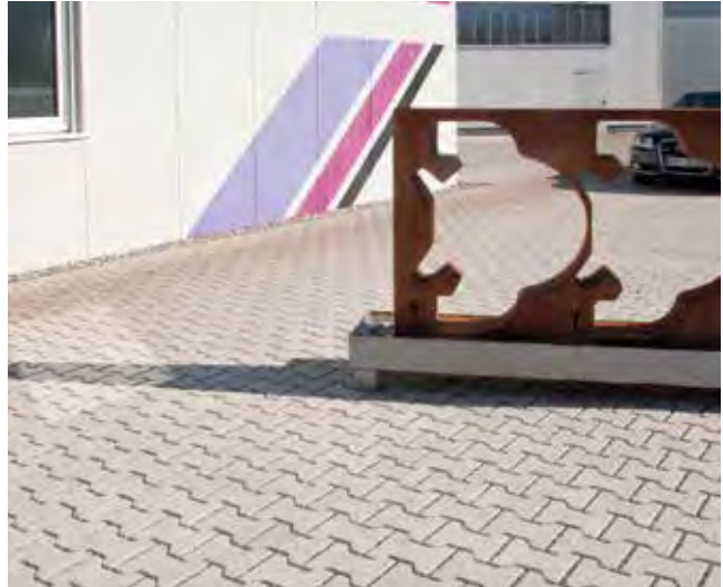
Klassik- und Verbundpflaster (Ökovariante I-Profil-Öko-Verbund)
