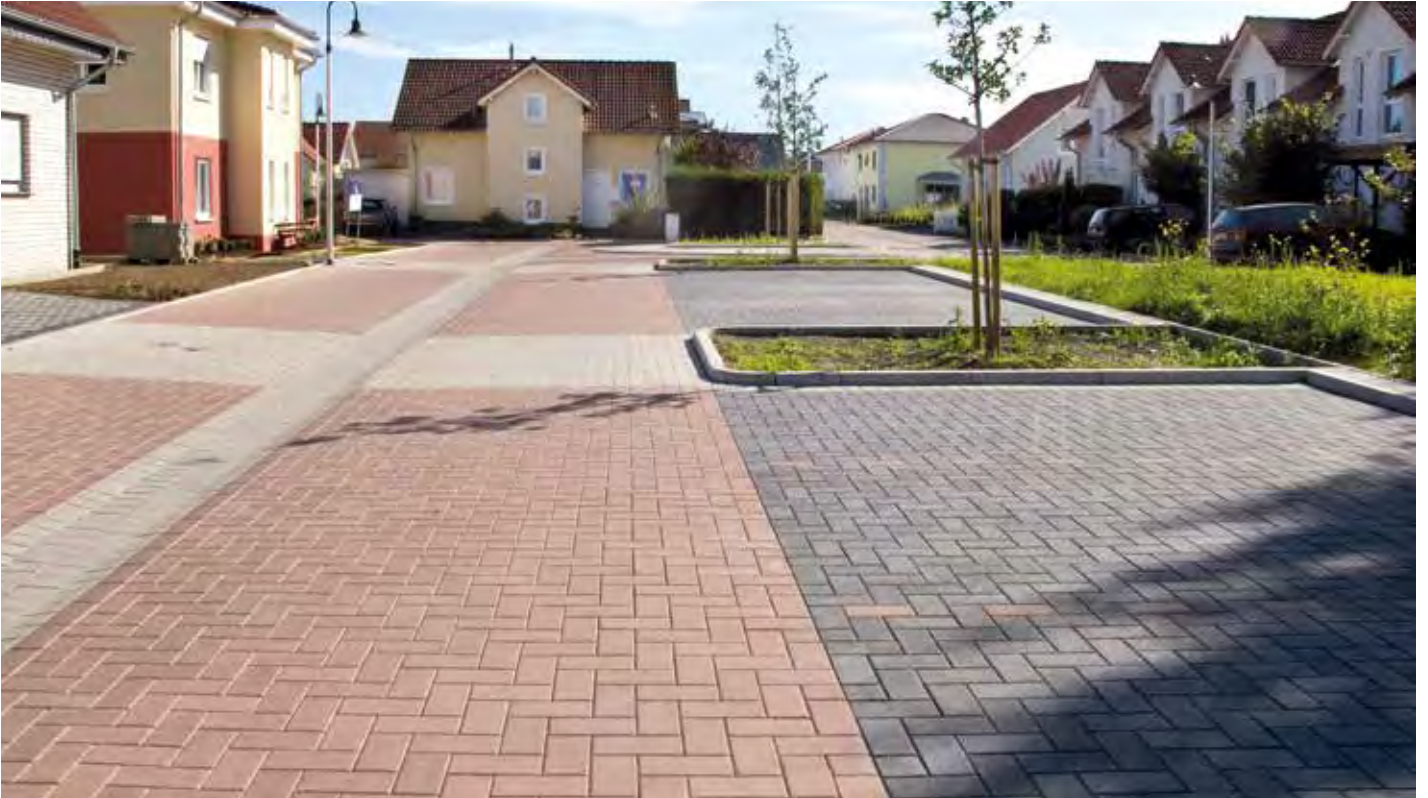
System 25-Objektpflaster mit Fase, 25×12,5 cm, anthrazit, braun und grau
