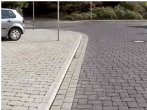
Altstadtpflaster gerumpelt, 24×16 cm und 16×16 cm, grau und anthrazit
