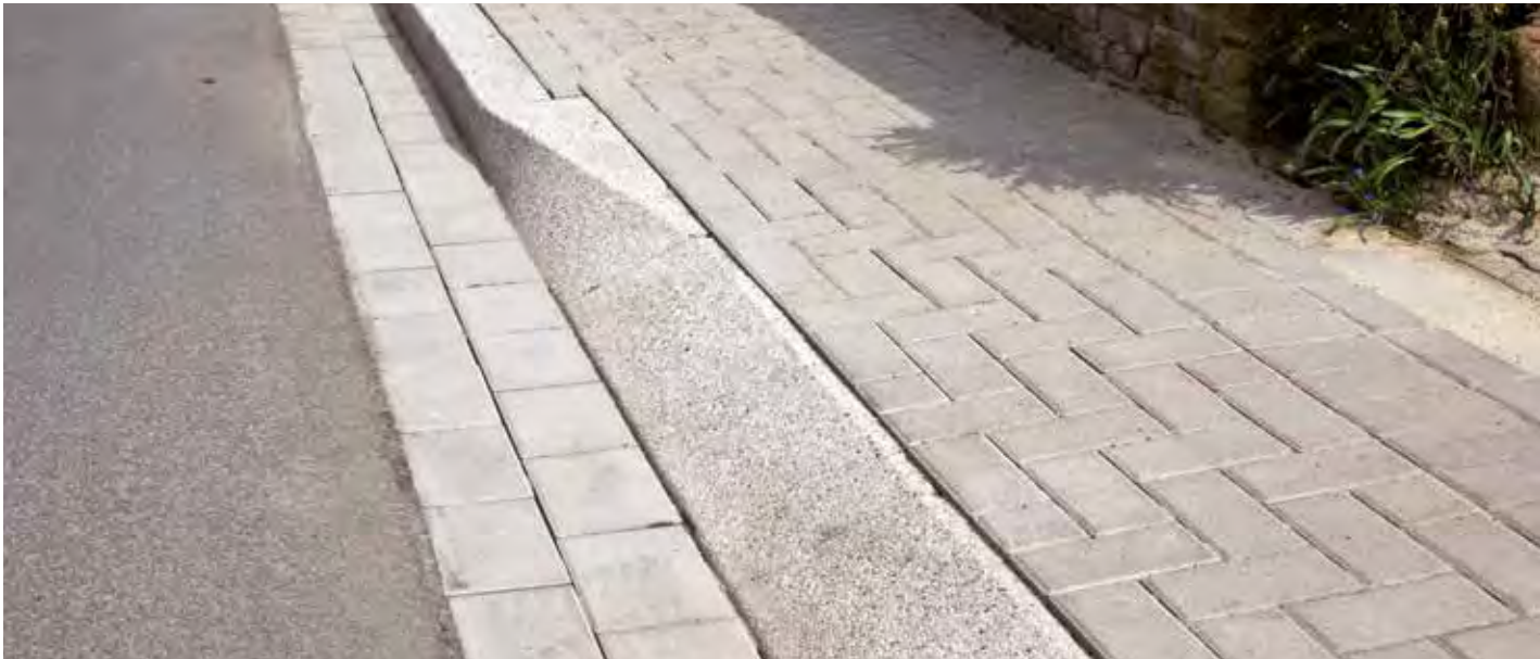
Fahrradbordstein/Schrägbordstein Typ 1, Übergangsstein auf Hochbordstein, quarz-hell gewaschen
