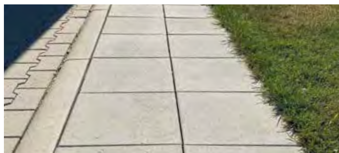
Geh- und Radwegplatte mit Fase, 40×40×5cm, grau
