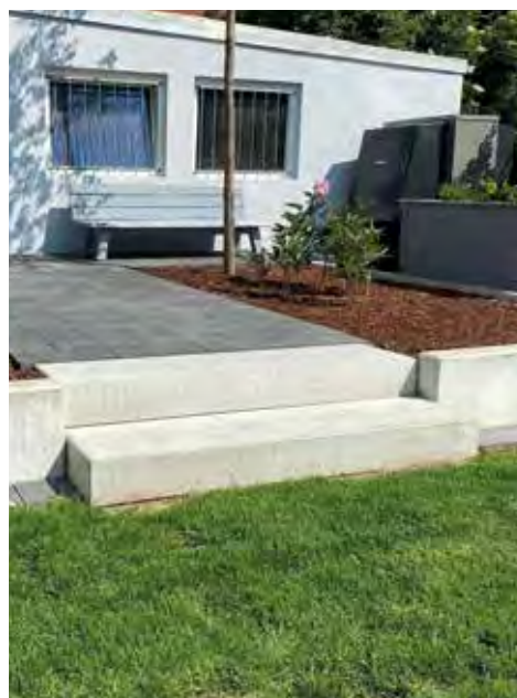
Blockstufen Nr. 4 Sichtbeton
