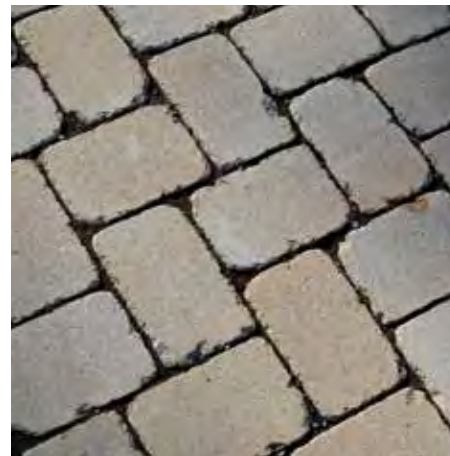
Integralpflaster gerumpelt, 22,5×15 cm, sandsteinfarbig nuanciert
