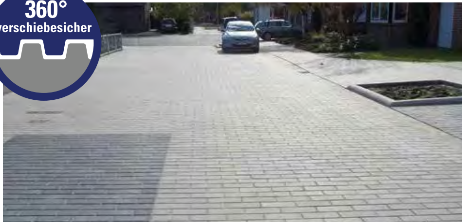
Integralpflaster mit Fasse, 30×15 cm, anthrazit und grau
