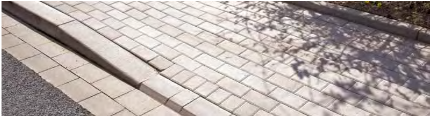
Hochbordsteine H 18×30, Schrammbinder mit 3 cm Abschrägung, Bindersteine ohne Fase, Requa 8er-Pflaster mit Fase, Tiefbordsteine T 8×25, grau
